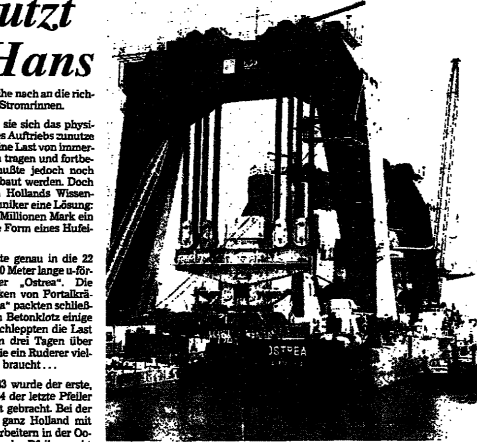
Mit dem Spezialschiff 'Ostrea' werden die 18 000 Tonnen schweren Hauptpfeiler an ihre Standorte gebracht.
